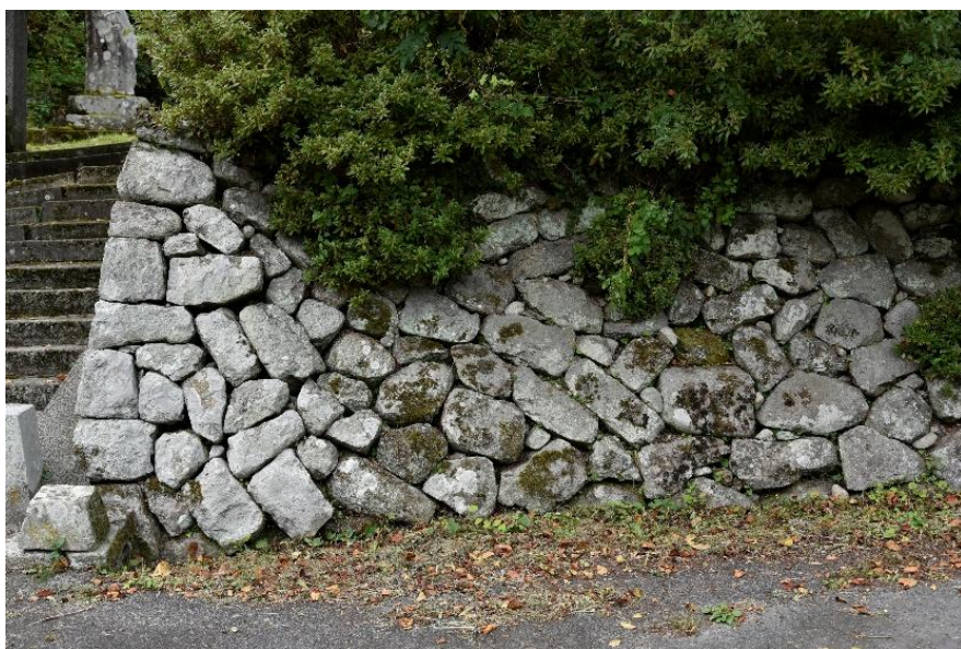
浄願寺の石垣（左端が隅角部）
